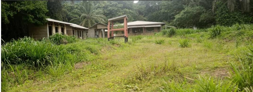
CS Some abandonné au village PK26
