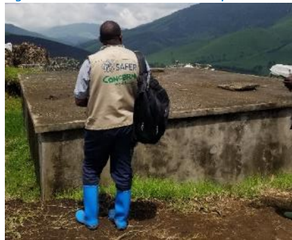
Figure 3 : Les deux réservoirs d'eau qui alimente la Zone
