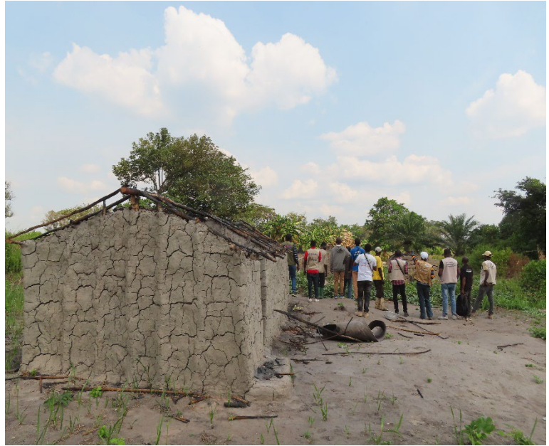
Visite des abris incendiés dans le village Mihemba avec les leaders communautaires
