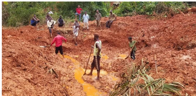
Travaux communautaires de détection de la source d'eau engloutie par les eaux des pluies et la boue, Quartier BIKUKU. 04/01/2024 © Victor DITUTU
