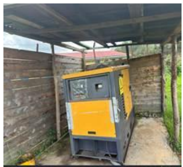
Générateur diesel de 20KA
