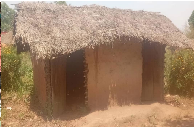
Etat de latrines et douches CS Schubert
