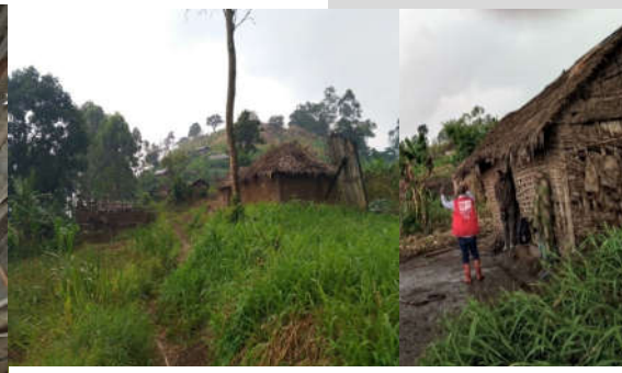
Abris non-durables délabrés à Munema Photo HEKS du 10/07/2026
