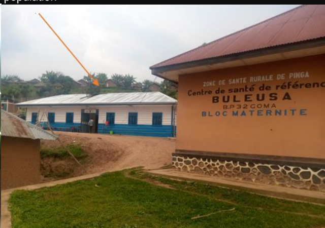
24/06/2022 (Buleusa) : En bleu-blanc : Bâtiment construit par MEDAIR au CSR Buleusa
