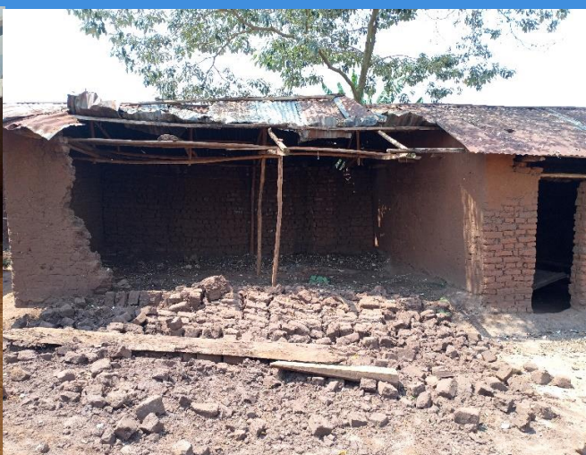
Kibirizi (09/08/2022) :Bâtiment du complexe scolaire La Douceur
