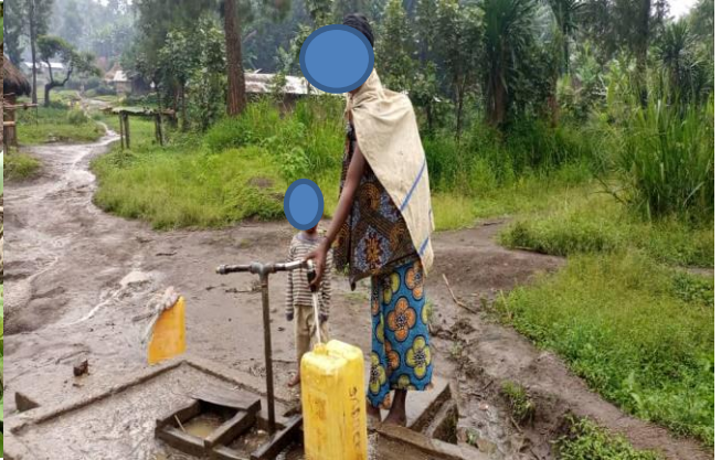
02/03/2022 (Nyabiondo) : Point de puisage avec un robinet non fonctionnel
