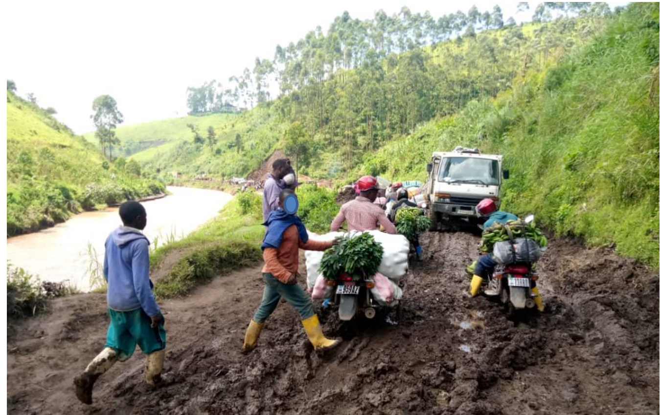
04/03/2022 (Kisuma) : Mauvais état de la route sur le tronçon Nyabiondo-Katale
