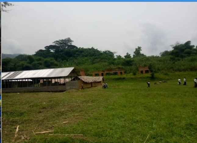
13/03/20220: Hangar abritant l'Institut Mutongo depuis la destruction de ses bâtiments en 2015
