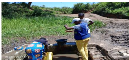
Source en mauvais état
