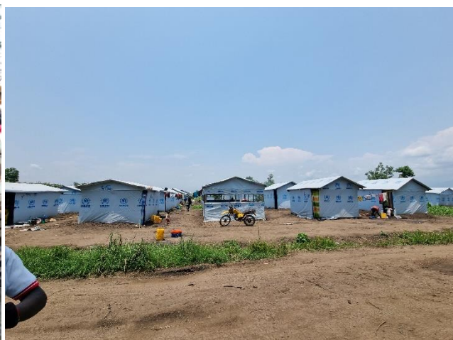
Figure 2 Vue sur le site de Rwassa 2 en construction
